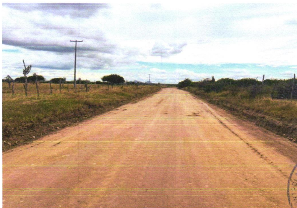
Foto 8 - EXECUÇÃO E COMPACTAÇÃO DE ATERRO COM SOLO PREDOMINANTEMENTE ARGILOSO - EXCLUSIVE SOLO, ESCAVAÇÃO, CARGA E TRANSPORTE. AF_11/2019
