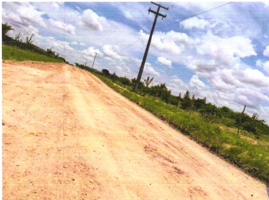
Foto 10 – EXECUÇÃO E COMPACTAÇÃO DE ATERRO COM SOLO PREDOMINANTEMENTE ARGILOSO - EXCLUSIVE SOLO, ESCAVAÇÃO, CARGA E TRANSPORTE. AF_11/2019
