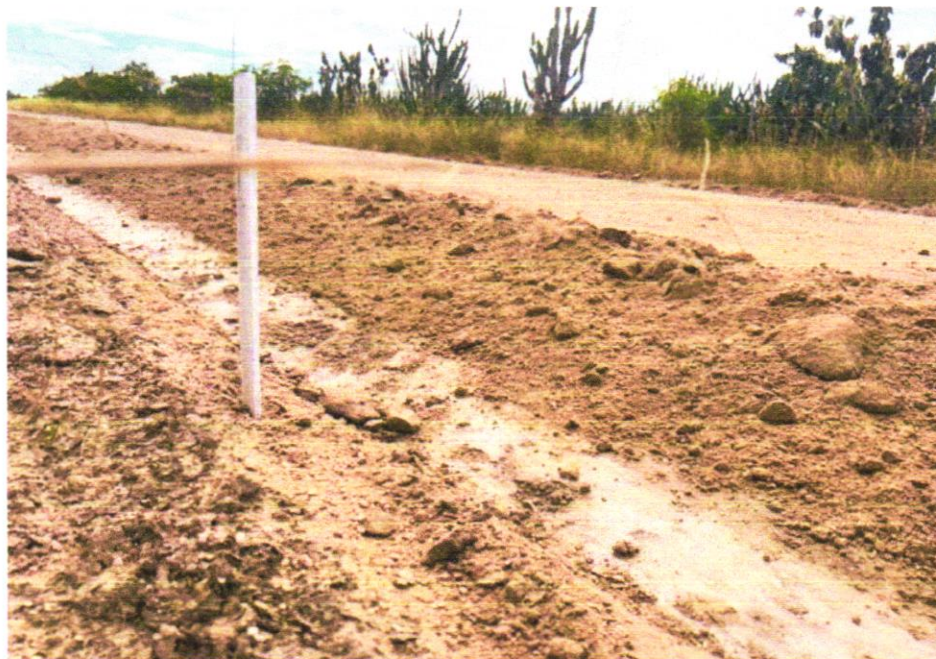
Foto 12 – EXECUÇÃO E COMPACTAÇÃO DE ATERRO COM SOLO PREDOMINANTEMENTE ARGILOSO - EXCLUSIVE SOLO, ESCAVAÇÃO, CARGA E TRANSPORTE. AF_11/2019
