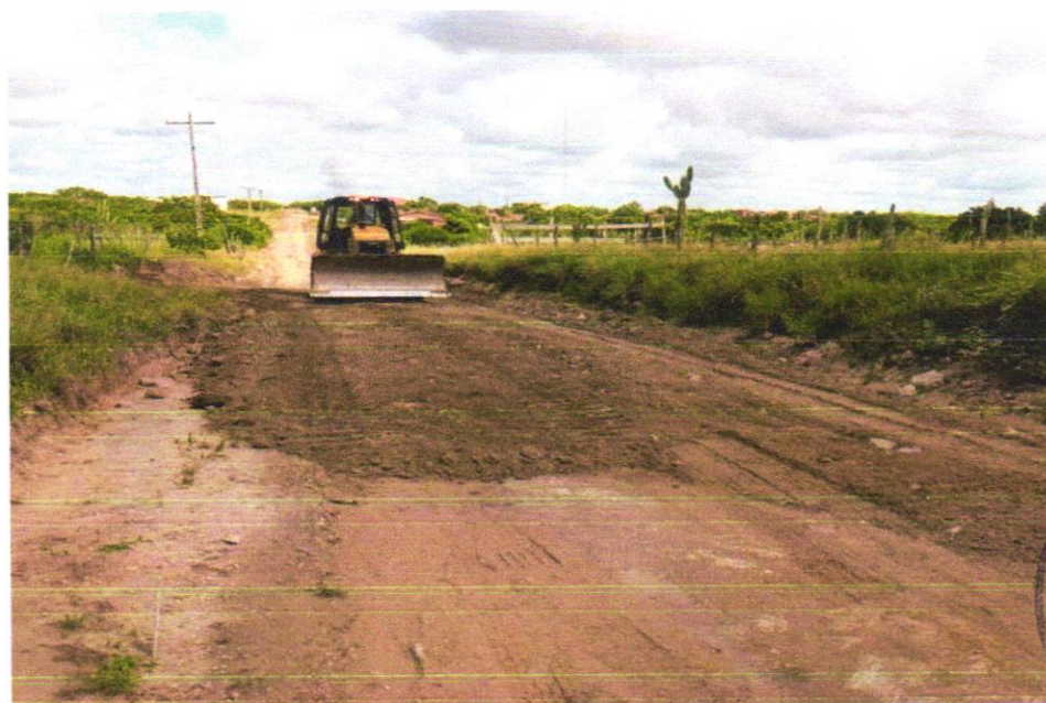
Foto 02 – ESCAVACAO E CARGA MATERIAL 1A CATEGORIA, UTILIZANDO TRATOR DE ESTEIRAS
