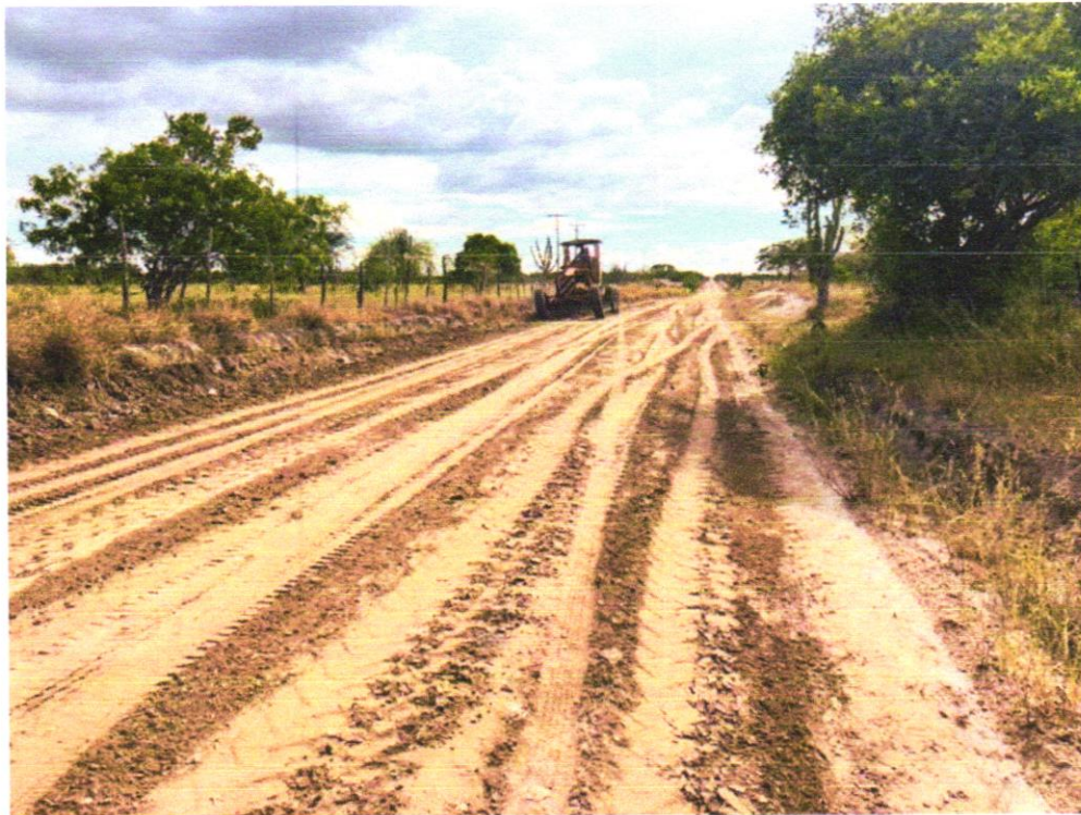
Foto 13 – ESPALHAMENTO DE MATERIAL COM TRATOR DE ESTEIRAS
