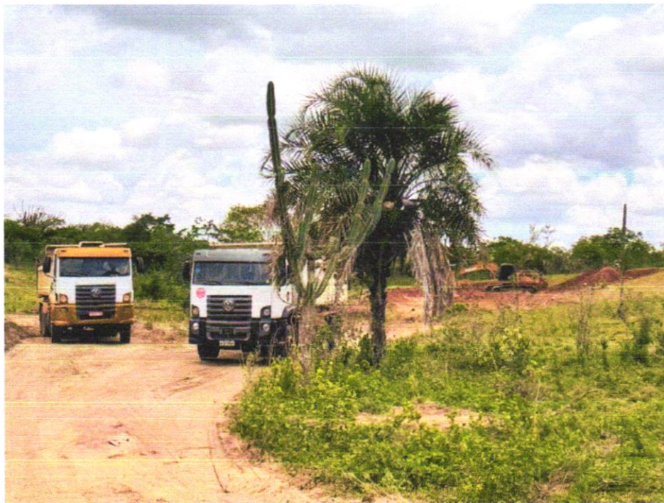
Foto 03- TRANSPORTE COM CAMINHÃO BASCULANTE DE 6 M 3 , EM VIA URBANA EM LEITO NATURAL (UNIDADE: M3XKM). AF_07/2020
