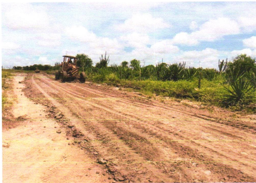
Foto 01 - REGULARIZAÇÃO DE SUPERFÍCIES COM MOTONIVELADORA
